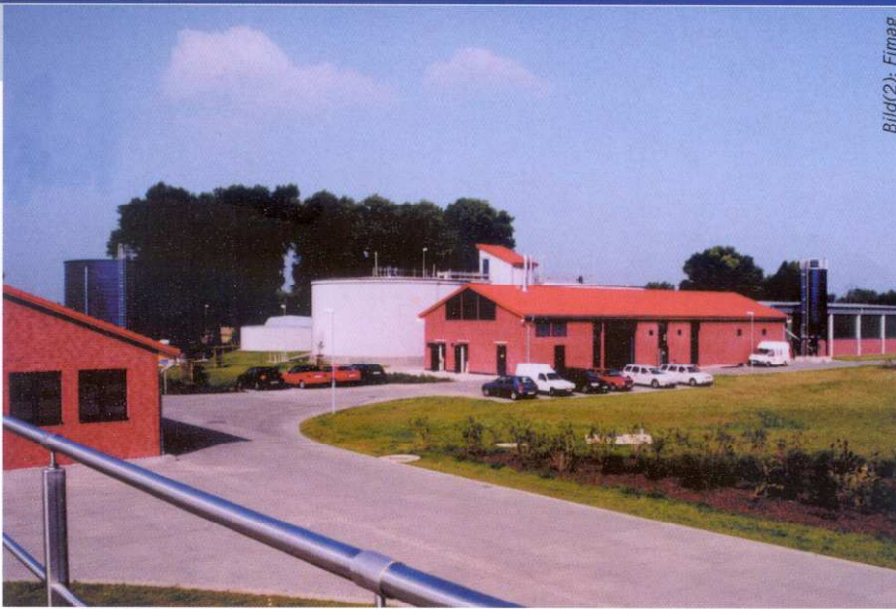
Die Kläranlage in Wolfenbüttel: Das Maschinengebäude im Vordergrund beherbergt das BHKW, die Netzersatzanlage, die Heizungsanlage, die Gasdruckerhöhung und die zentrale Schmierölvorsorgung. Bild(2): Fimag
